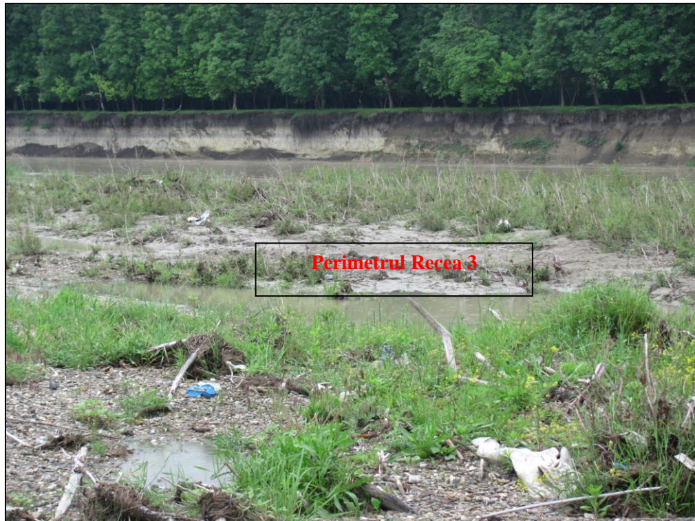
Perimetrul Recea 3 inundat la ape mari – ape care "spală" malul stâng de coperta subțire de sol și afectează vegetația ierboasă, iar pe de altă parte erodează malul drept determinând prăbușirea unor suprafețe
