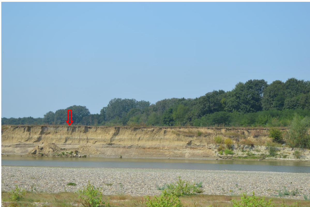
Eroziune activă mal drept în dreptul perimetrului Ion Creangă 2
