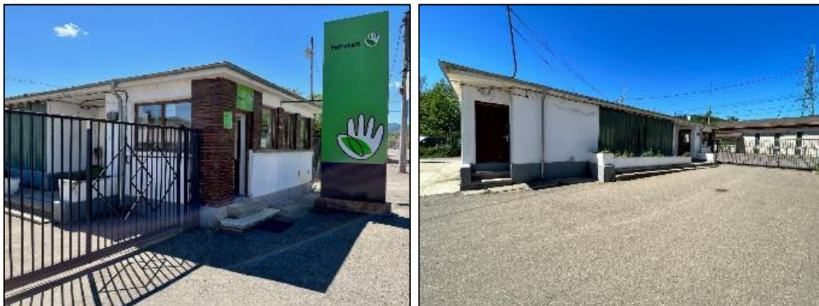
C2-C3- Clădire pentru cabina portar si cantina (nr. cadastral NC 54 650)
