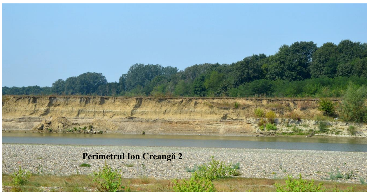
Eroziune activă mal drept în zona primetrului Ion Creangă 2
