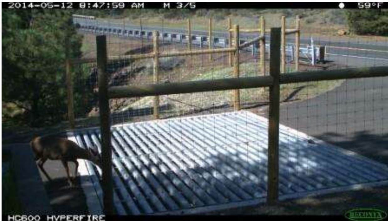
Figura nr. 5-9 A. Exemplu al unui grilaj electricat pentru fauna sălbatică; B Exemplu al unui panou de avertizare montat pe un drum din Țara Galilor pentru a atenționa șoferii cu privire la prezența unui grilaj; C. Grilaj instalat pentru a evita pătrunderea faunei sălbatice pe carosabilul unui drum din Washington, SUA
