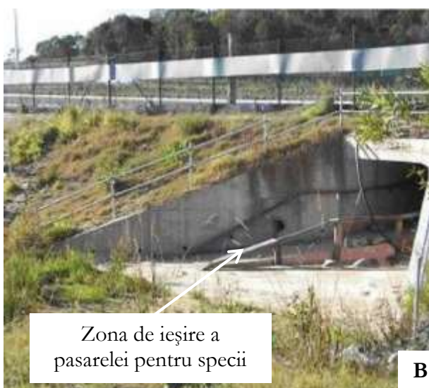
Figura nr. 5-11 A. Subtraversare adaptată pentru particularitățile de deplasare a mai multor specii; B. Zona de ieșire a unei subtraversări adaptată pentru mai multe specii; C: Exemplu de utilizare al unei pasarele de către un individ al speciei Lutra lutra
