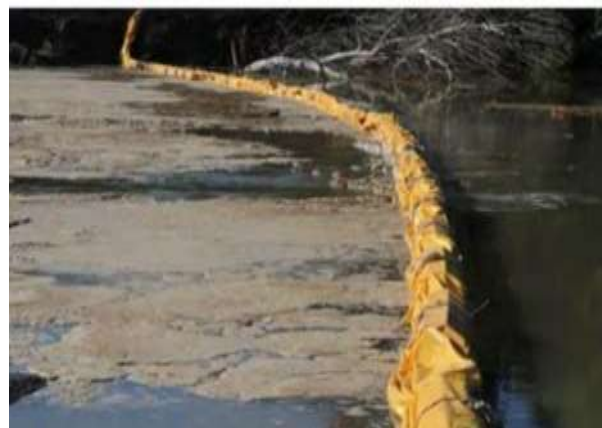
Figura nr. 5-14 Exemplu de barieră plutitoare pentru controlul sedimentelor în apă (sursa: https://www.epd.gov.hk )
