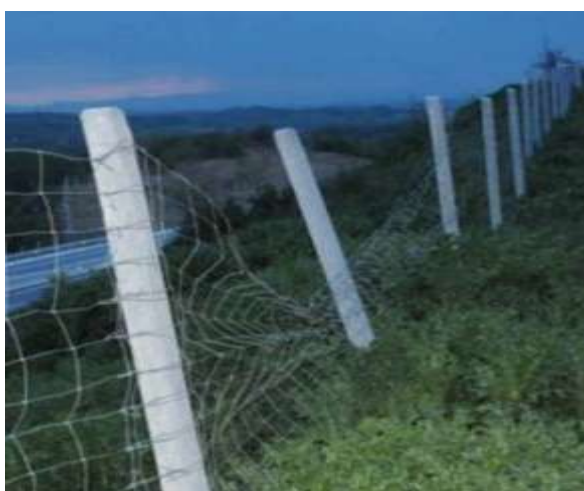
Figura nr. 5-3 Exemplu al unui gard rupt în zona autostrăzii și consecințelor modului de proiectare al acestuia
