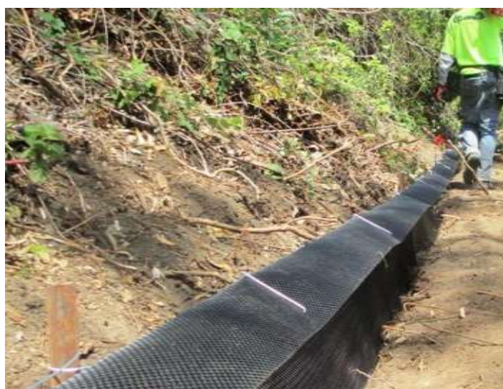
Figura nr. 5-6 Exemplu al unui gard permanent pentru amfibieni și reptile (Sursa: ERTEC Environmental Systems)
