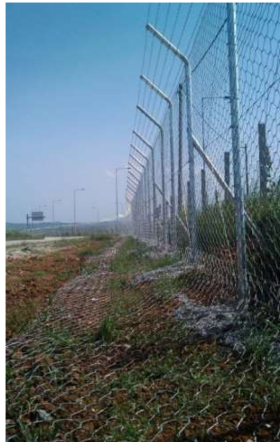
Figura nr. 5-4 A. Schema gardului ranforsat utilizat la Egnatia; B. Gardul ranforsat nou instalat în paralel cu gardul vechi; C. Exemplu al soluției utilizate pentru a preveni pătrunderea faunei sălbatice pe sub gardul ranforsat
