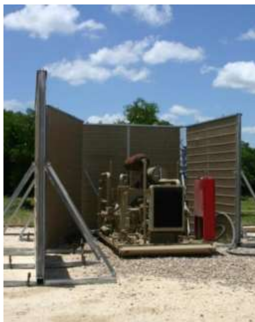
Figura nr. 5-15 Exemplu de panouri fonoabsorbante mobile recomandate pentru lucrările de construcție ale autostrăzii Târgu Mureș – Târgu Neamț
