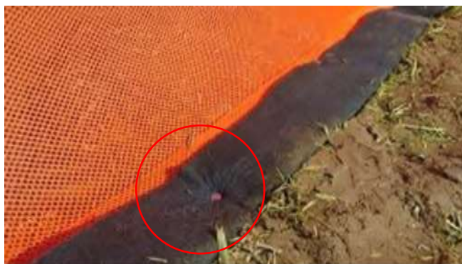
Figura nr. 5-7 Securizarea părții inferioare a gardului în sol
