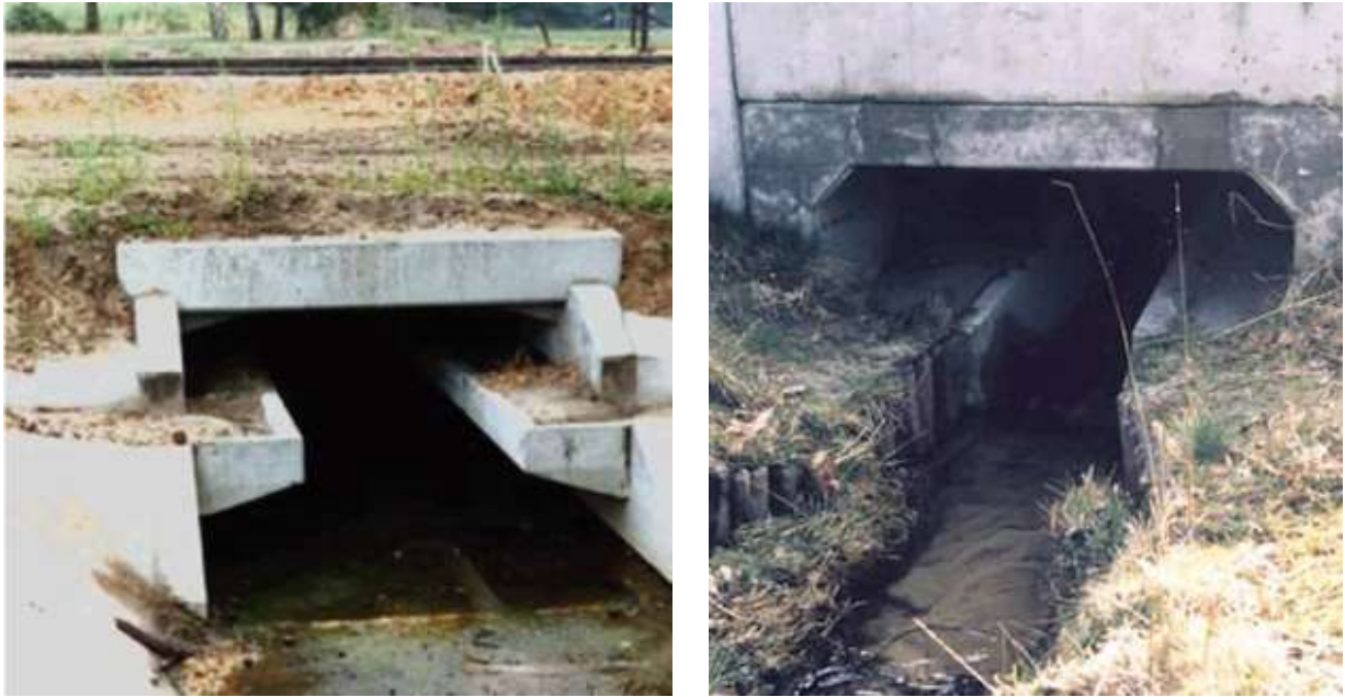
Figura nr. 5-10 Exemple ale unor subtraversări pentru specii de faună de dimensiuni mici, similare celor propuse ca măsură pentru menținerea conectivității
