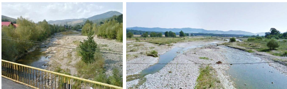
Figura nr. 3-23 Corpul de apă Ozana (Boboiești) în zona de intersectare cu proiectul
