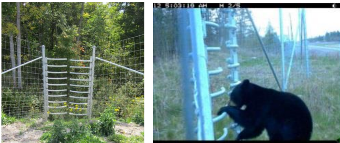
Figura nr. 5-20 Exemple ale unor porți de ieșire pentru fauna sălbatică ajunsă în zona carosabilului autostrăzii
