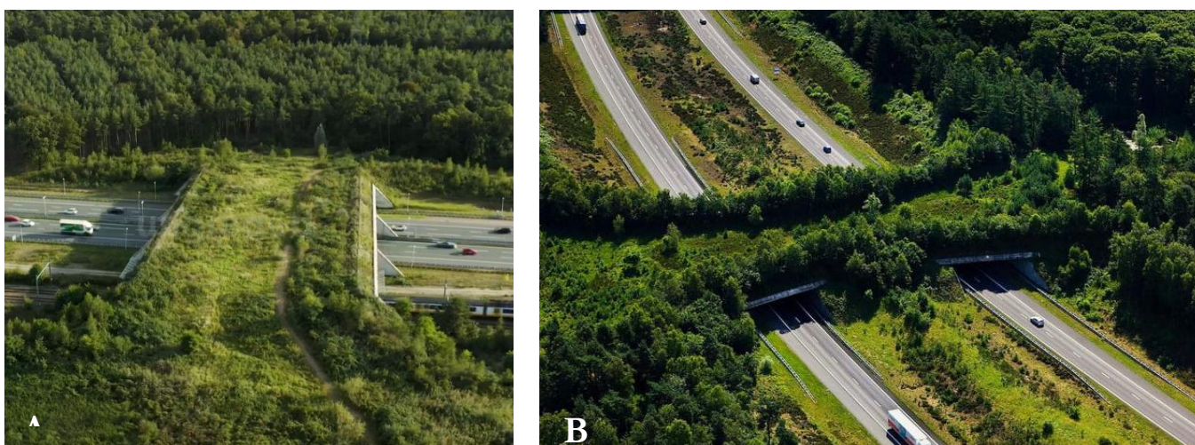
Figura nr. 5-28 Exemple de ecoducte propuse în Olanda (A) și Statele Unite ale Americii (B) 14
