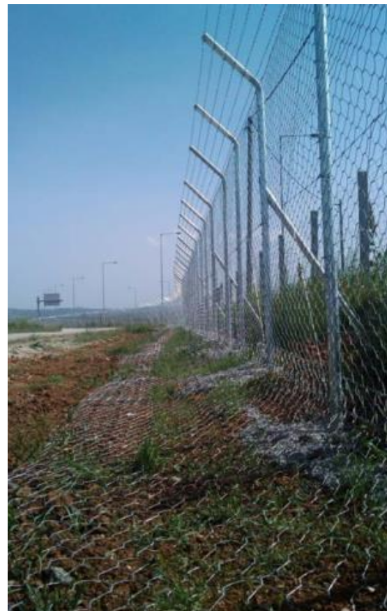
Figura nr. 5-19 A. Schema gardului ranforsat utilizat la Egnatia; B. Gardul ranforsat nou instalat în paralel cu gardul vechi; C. Exemplu al soluției utilizate pentru a preveni pătrunderea faunei sălbatice pe sub gardul ranforsat
