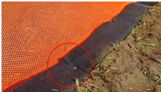
Figura nr. 5-22 Securizarea părții inferioare a gardului în sol
