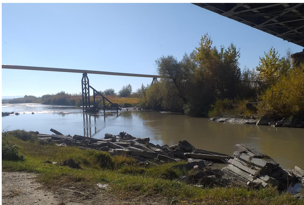
Figura - Albia râului Moldova aval de pod km.343+714 și conductă deținută de TRANSGAZ ce supratraversează albia râului
