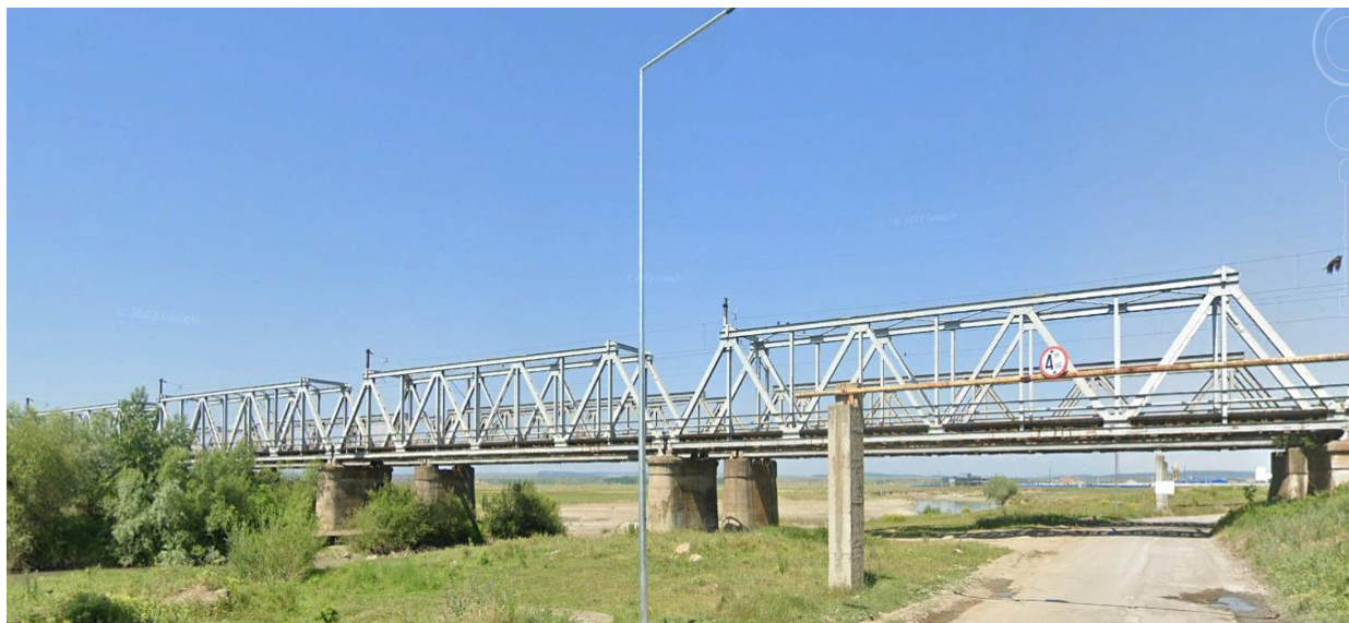
Figura 3.- Pod km.343+714, linia de cale ferată Ploiești – Vicșani – zona culeei Roman
