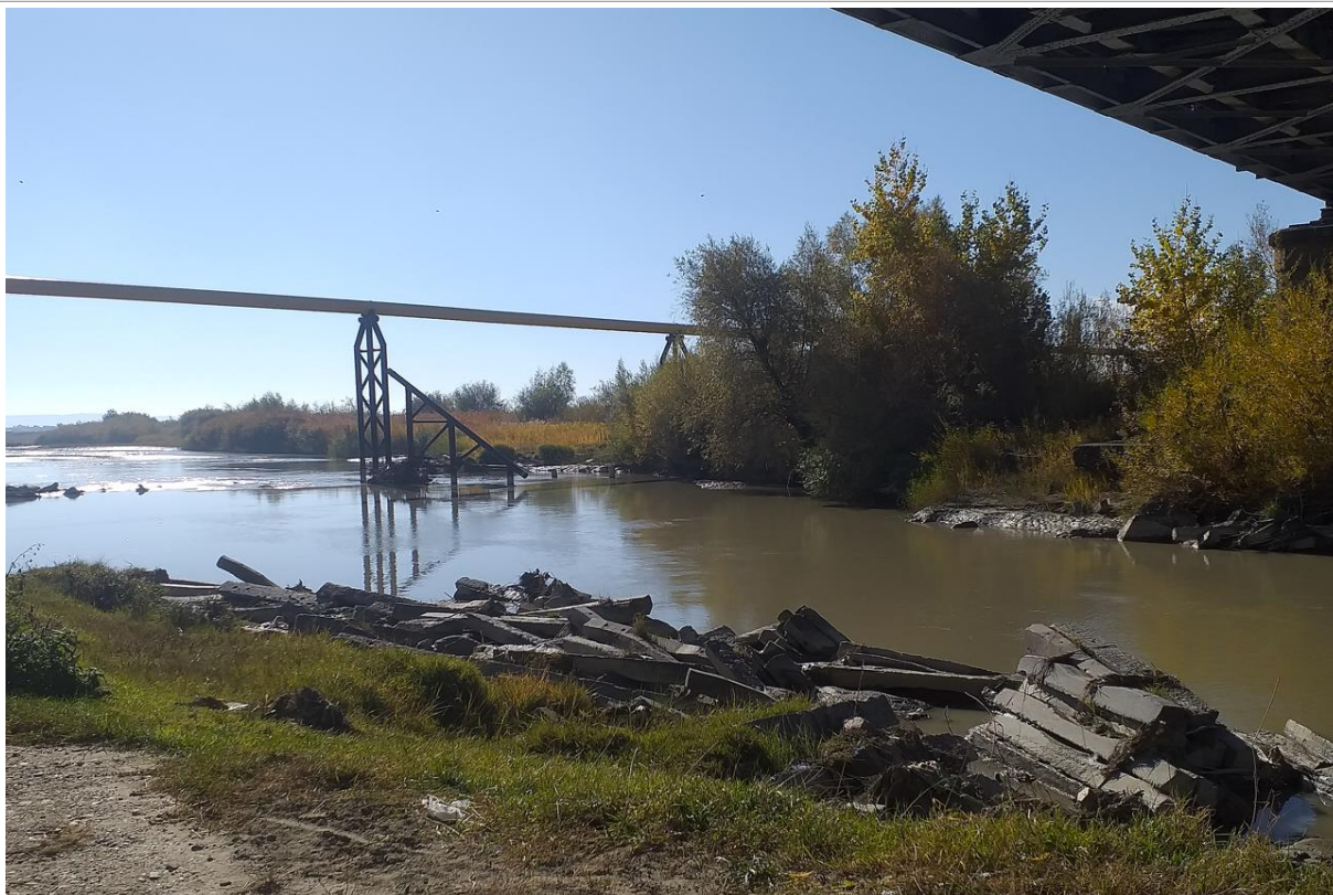
Figura 2. Albia râului Moldova aval de pod km.343+714 și conductă deținută de TRANSGAZ ce supratraversează albia râului
