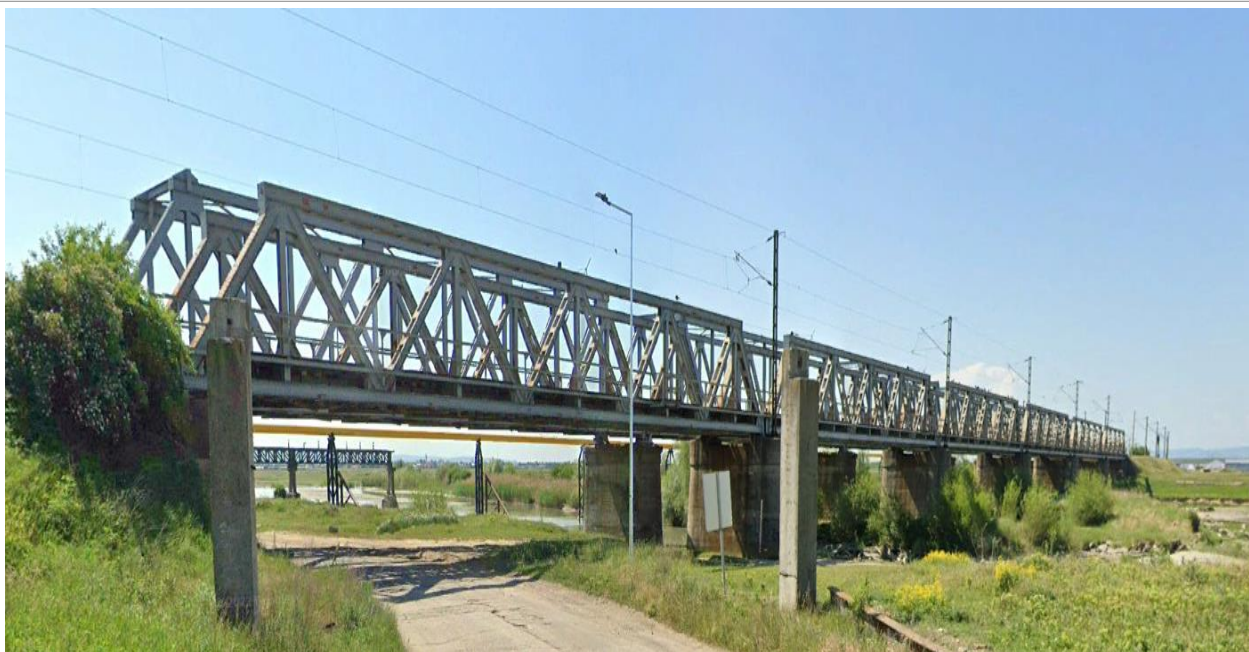
Figura 4. Pod cf km.343+714 pe linia de cale ferată Ploiești - Vicșani, culeea Roman
