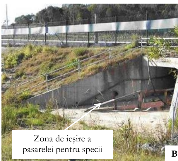
Figura nr. 5-26 A. Subtraversare adaptată pentru particularitățile de deplasare a mai multor specii; B. Zona de ieșire a unei subtraversări adaptată pentru mai multe specii; C: Exemplu de utilizare al unei pasarele de către un individ al speciei Lutra lutra
