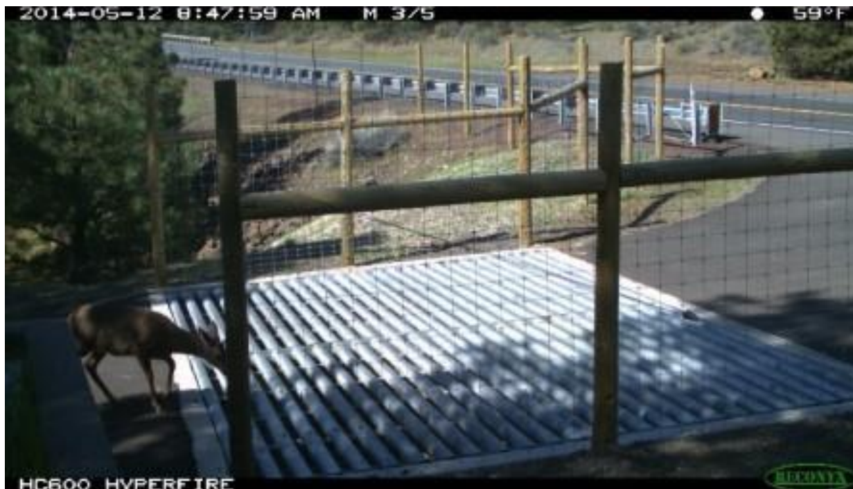
Figura nr. 5-24 A. Exemplu al unui grilaj electricat pentru fauna sălbatică; B Exemplu al unui panou de avertizare montat pe un drum din Țara Galilor pentru a atenționa șoferii cu privire la prezența unui grilaj; C. Grilaj instalat pentru a evita pătrunderea faunei sălbatice pe carosabilul unui drum din Washington, SUA
