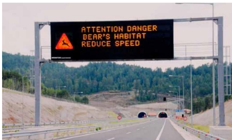
Figura nr. 5-37 Exemple ale unor panouri de atenționare referitoare la riscul de coliziune. Panoul de atenționare din poza B este activat de senzori doar în perioadele când este detectată prezența faunei sălbatice
