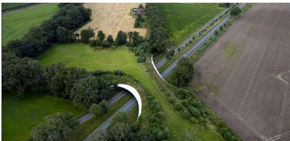
Figura nr. 5-27 Exemplu de ecoduct pentru care este realizată o legătură între vegetația de pe ecoduct și vegetația din marginile parcelelor agricole (sursa: https://c8.alamy.com/zooms/9/0c8a6d6aa4f74c8a84c3a13aa62a4a3b/2gf2xk6.jpg )
