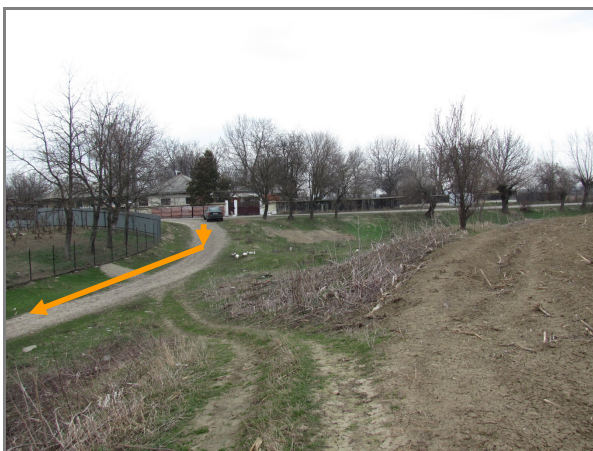
Intrarea din DC spre stația de epurare
