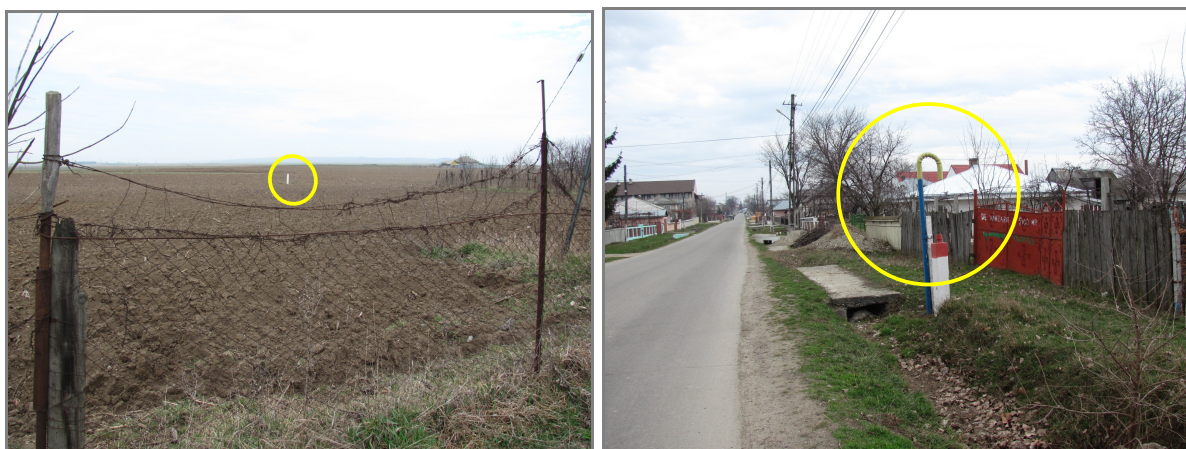
Pichet și conductă transport gaze naturale în zona de subtraversare
