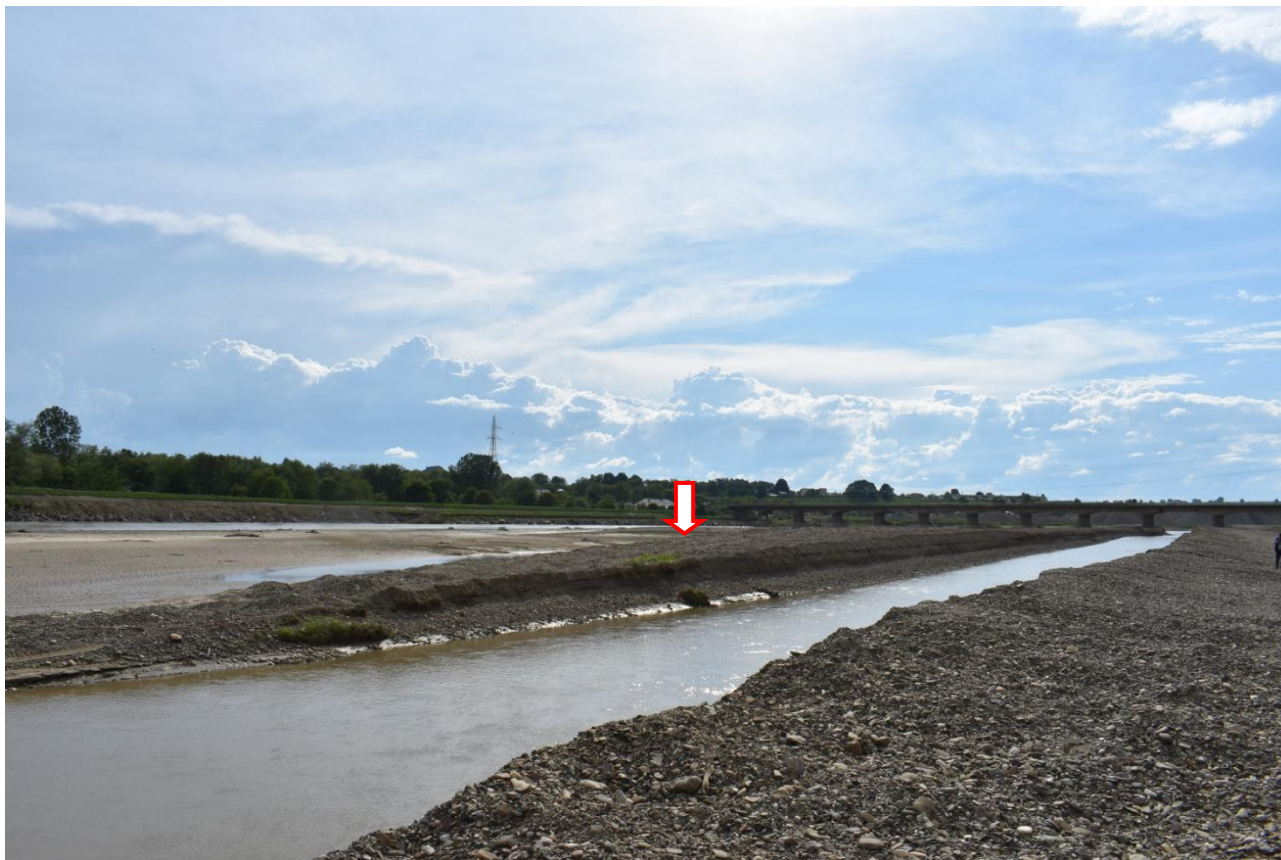
Acumularea de aluviuni din perimetrul Tupilați aval pod
