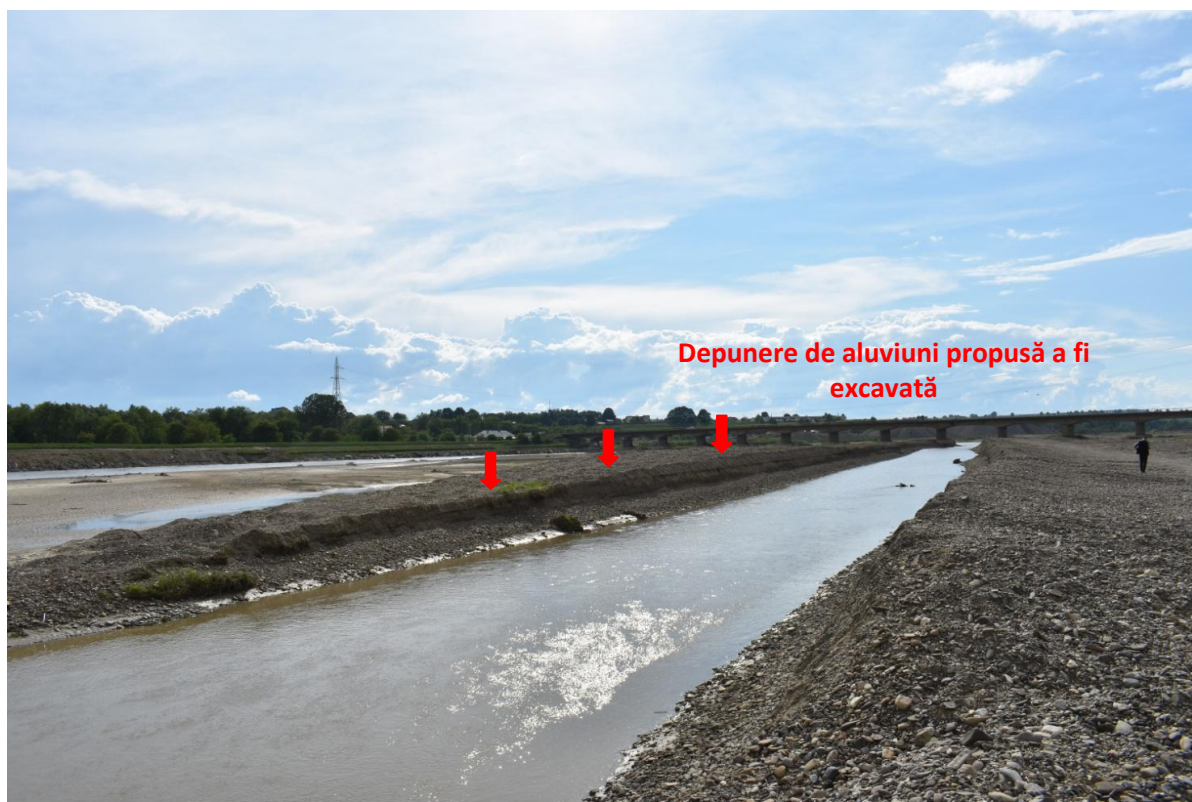
Aspectul perimetrului Tupilați Aval Pod
