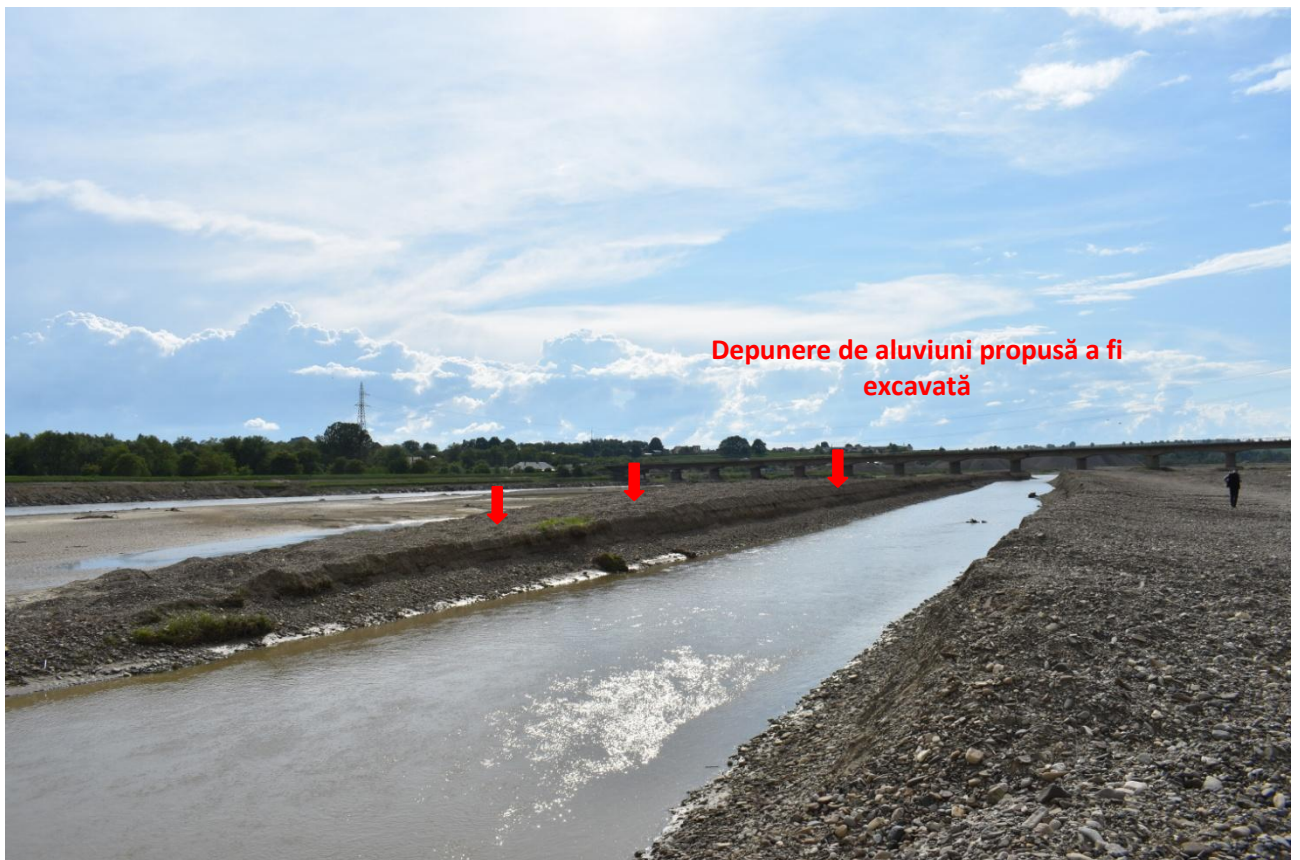
Aspectul perimetrului Tupilați Aval Pod
