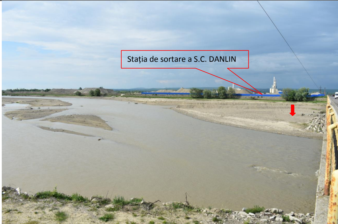
Aspectul perimetrului Tupilați Amonte Pod
