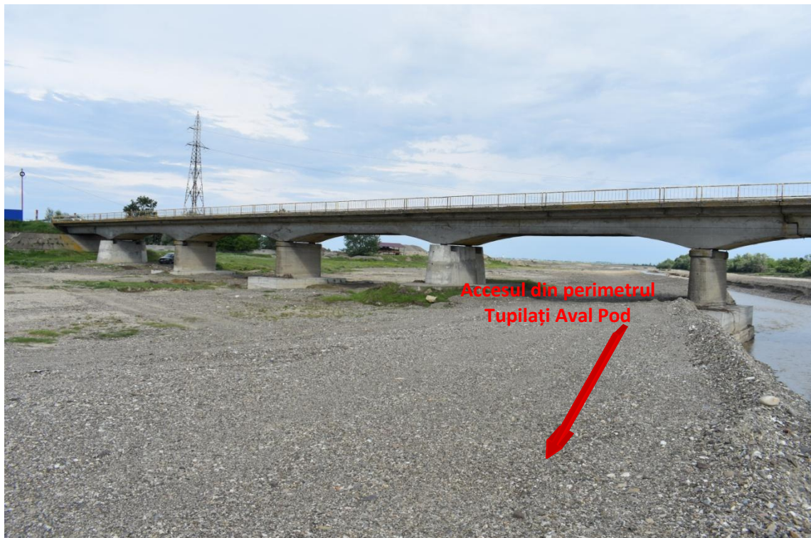
Aspectul habitatelor din vecinătatea amplasamentului și accesul din perimetrul Tupilați Aval Pod
