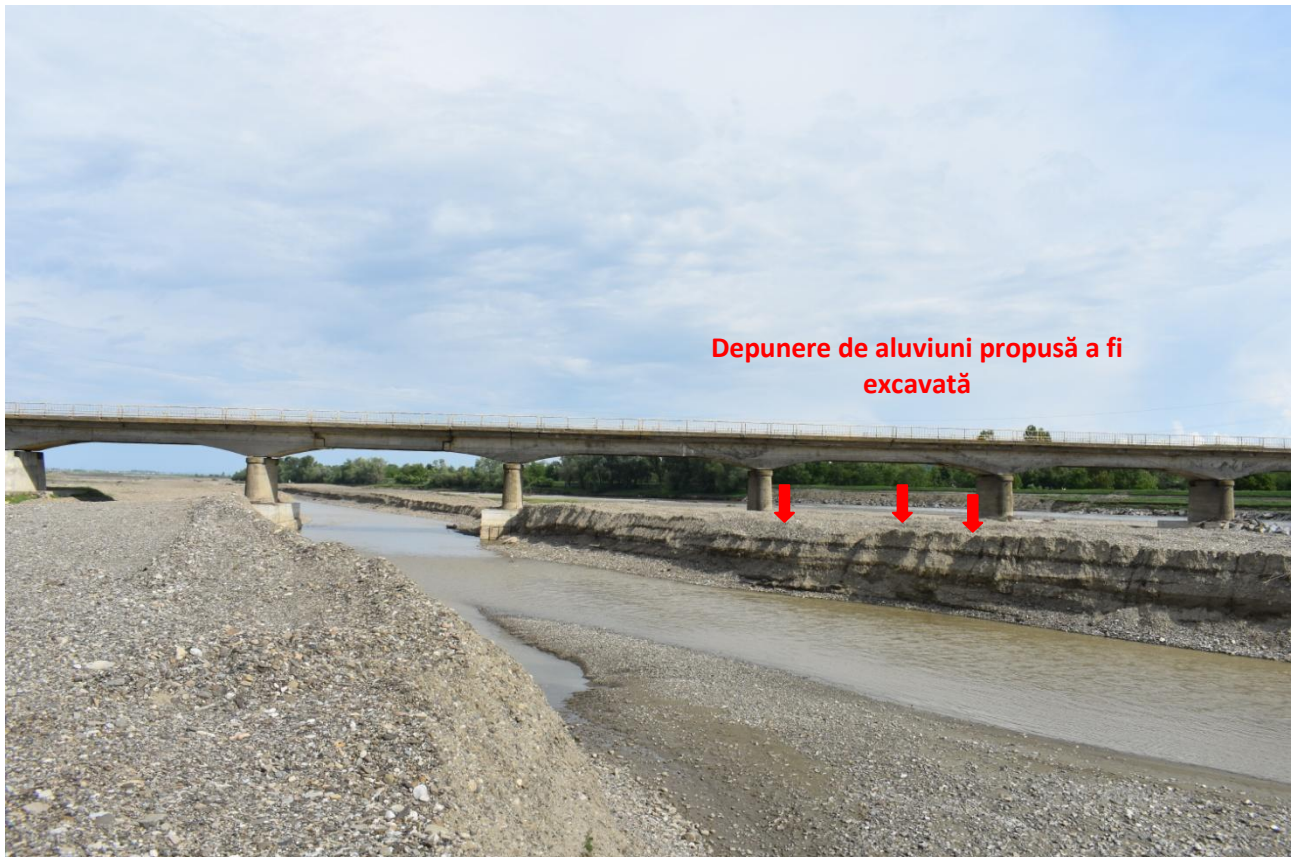
Aspectul perimetrului Tupilați Amonte Pod
