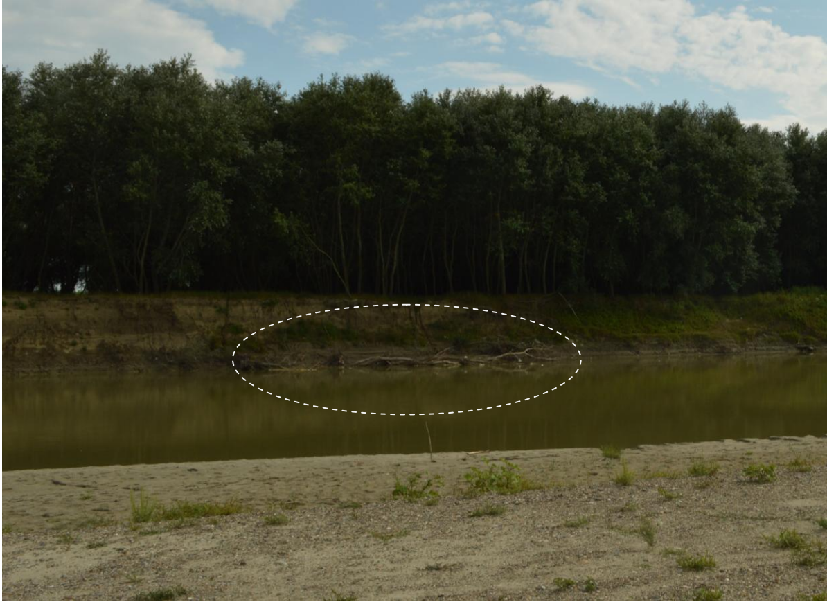
Vegetație lemnoasă prăbușită în albia râului Siret pe malul stâng în dreptul perimetrului Hârlești amonte 3
