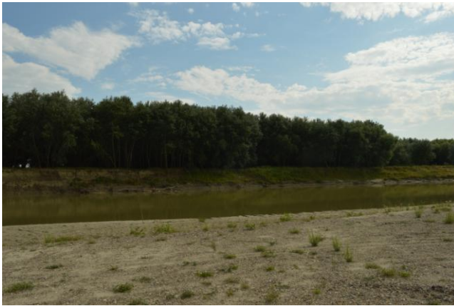
Eroziunea malului stâng în dreptul perimetrului Hârlești Amonte 3
